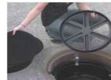
coalsi ®-Hybridaktivkohlematte in den Siphon einsetzen.
