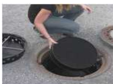
coalsi ®-Hybridaktivkohlematte zusammen mit dem Siphon einsetzen.
