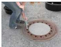
Schachtabdeckung mit Deckelheber entfernen.
