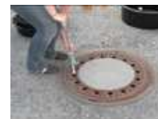
Schachtabdeckung mit Schachdeckelheber einsetzen.
