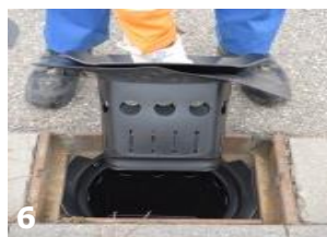
6 coalsi® Filterrahmen mit Dichtung einsetzen
