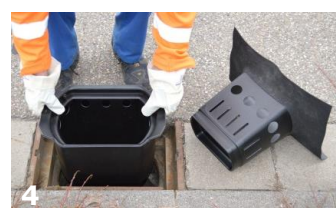
4 coalsi® Grundkörper einsetzen
