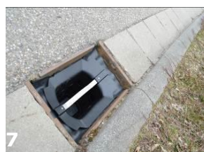
7 coalsi® Filterrahmen mit Dichtung einsetzen
