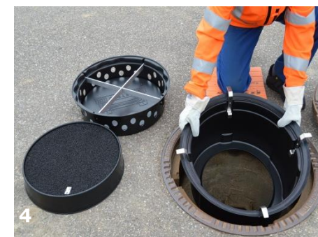
coalsi® Grundkörper einsetzen
