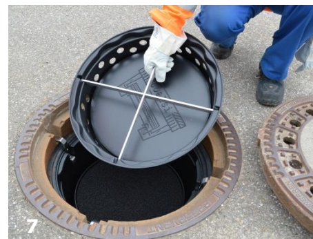
coalsi® Laubfang in Grundkörper einsetzen
