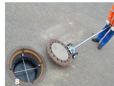
Schachtabdeckung mit Schachtdeckelheber wieder einsetzen
