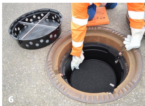
coalsi® Hybrid-Aktivkohlefilter zusammen mit Siphon einsetzen
