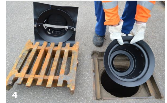
coalsi® Grundkörper einsetzen
