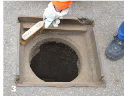
Auflage-und Dichtfläche reinigen
