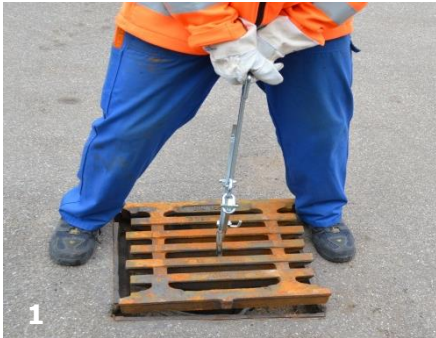
Schachtabdeckung mit passendem Schachtdeckel- heber entfernen
