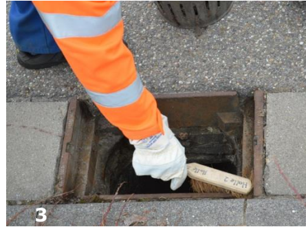
3 coalsi® Auflage- und Dichtfläche reinigen
