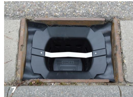
7 coalsi® Filterrahmen mit Dichtung einsetzen
