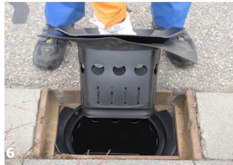
6 coalsi® Filterrahmen mit Dichtung einsetzen
