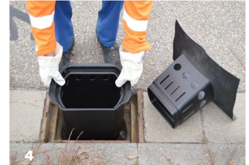
4 coalsi® Grundkörper einsetzen
