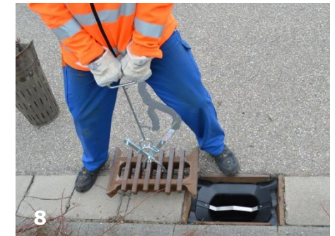
8 Schachtabdeckung mit passendem Schachtdeckel- heber wieder einsetzen
