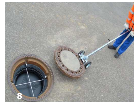
Schachtabdeckung mit Schachtdeckelheber wieder einsetzen
