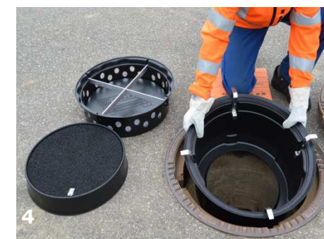
coalsi® Grundkörper einsetzen
