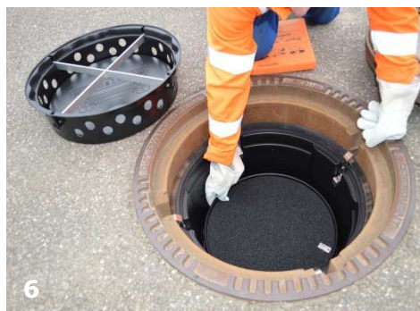
coalsi® Hybrid-Aktivkohlefilter zusammen mit Siphon einsetzen
