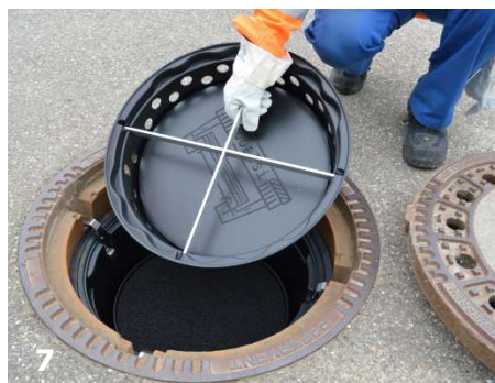
coalsi® Laubfang in Grundkörper einsetzen
