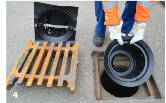
coalsi® Grundkörper einsetzen
