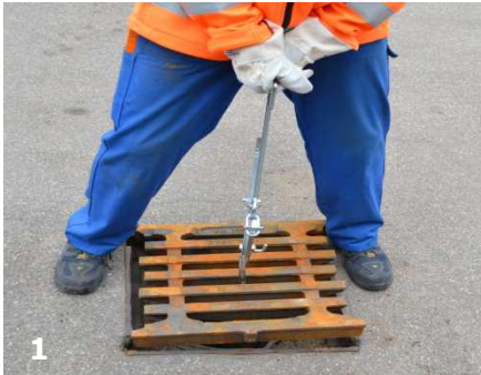
Schachtabdeckung mit passendem Schachtdeckel- heber entfernen
