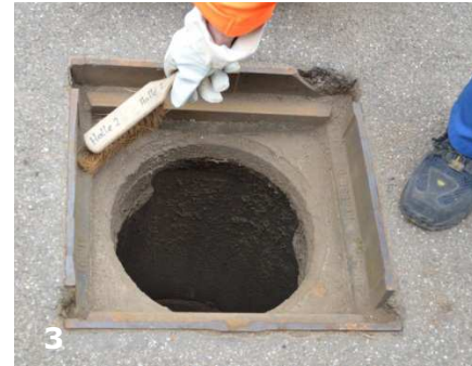
Auflage- und Dichtfläche reinigen
