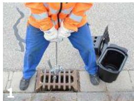
1 Schachtabdeckung mit passendem Schachtdeckelheber entfernen
