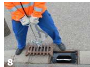
8 Schachtabdeckung mit passendem Schachtdeckelheber wieder einsetzen
