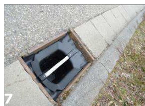
7 coalsi® Filterrahmen mit Dichtung einsetzen
