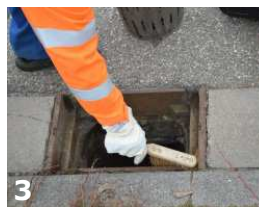
3 coalsi® Auflage- und Dichtfläche reinigen
