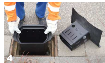
4 coalsi® Grundkörper einsetzen
