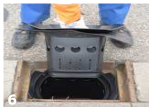
6 coalsi® Filterrahmen mit Dichtung einsetzen
