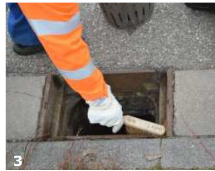
coalsi® Auflage-und Dichtfläche reinigen
