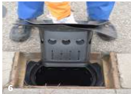
coalsi® Filterrahmen mit Dichtung einsetzen
