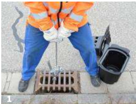
Schachabdeckung mit passendem Schachtdeckel- heber entfernen
