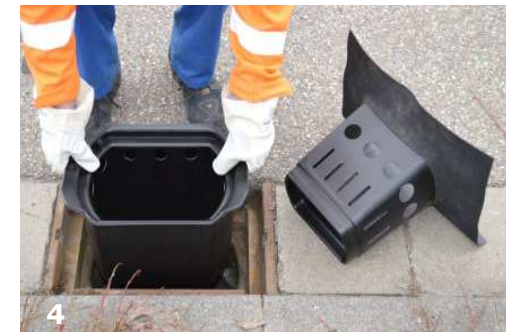
coalsi® Grundkörper einsetzen
