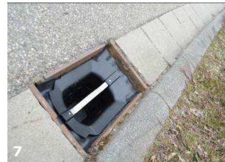
coalsi® Filterrahmen mit Dichtung einsetzen
