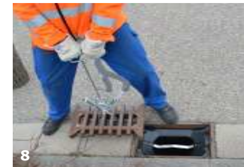
Schachabdeckung mit passendem Schachtdeckel- heber wieder einsetzen
